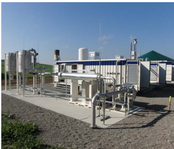
Figurtekst: Diagram af opgraderingsenhed, der anvender membranteknologi gasfiltrering; Foto af opgraderingsanlægget Kisslegg, Tyskland. Gaskapacitet 500 m 3 /time (Kilde: AXIOM Angewandte Prozesstechnik)
