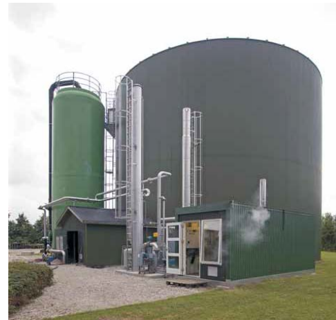
Figurtekst: Diagram af opgraderingsenhed, der anvender amin vaskeproces; Foto af opgraderingsanlægget Hashøj, Danmark. Gaskapacitet 250 m 3 /time (Kilde: Ammongas A/S)
